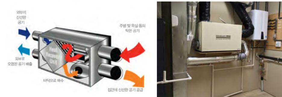
열회수형 환기장치의 작동 원리와 설치 모습
